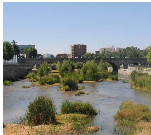
Tramo de renaturalización del río Manzanares
